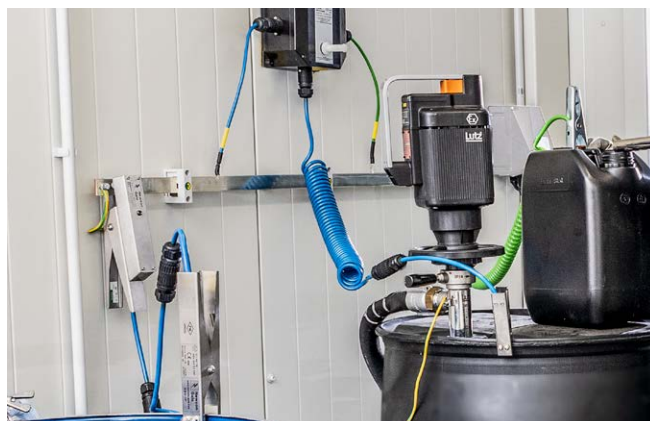
Wewnętrzna szyna uziemiająca z wyprowadzonym na zewnątrz trzpieniem podłączającym uziemienie zapewniają niezbędne wyrównanie potencjału.
