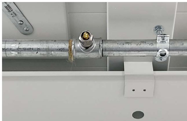
Zraszacz mgły wodnej minimalizuje użycie wody gaśniczej do gaszenia pożarów wrażliwych substancji niebezpiecznych.
