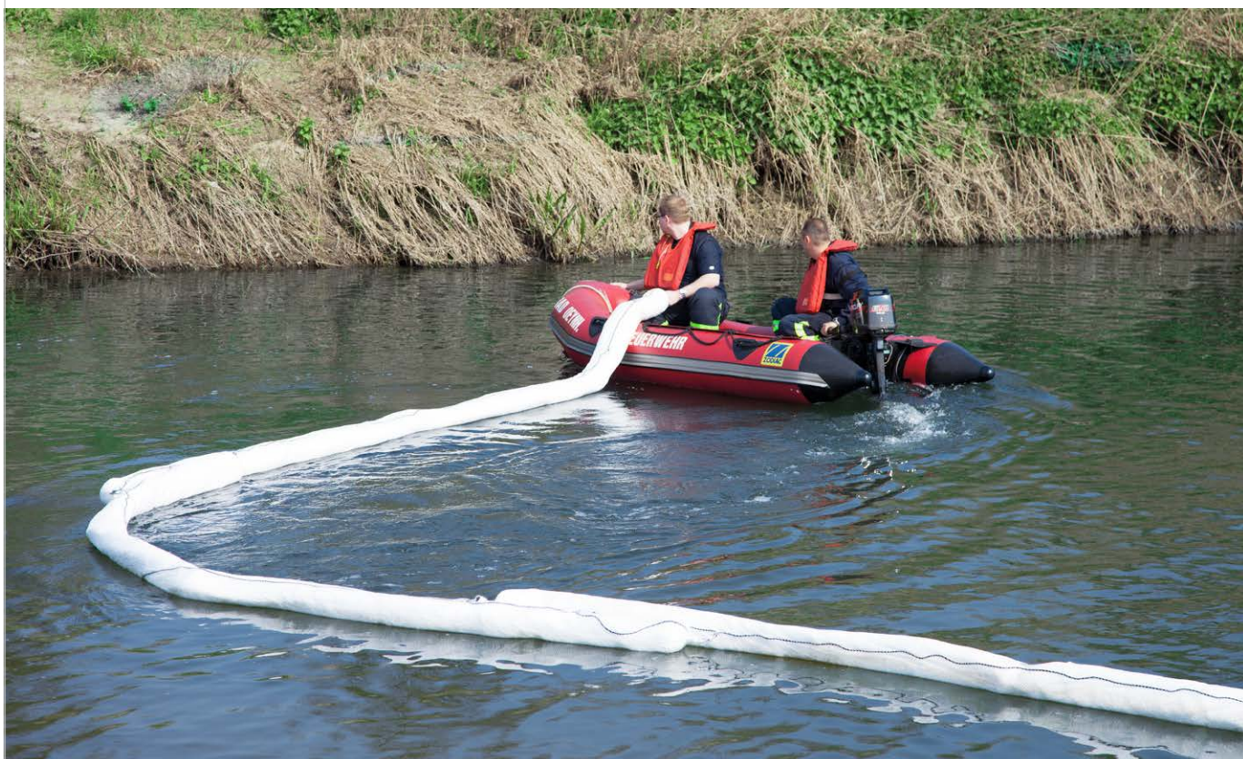
Zapory przeciwolejowe DENSORB (tu: segmenty 6 m) do otamowania wycieku i zbierania zanieczyszczeń olejowych z powierzchni wód
