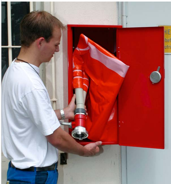
Szybko gotowe do użytku, mobilne uszczelnienie drzwi (długość: 2 m), z szafką stalową do przechowywania na miejscu użycia
